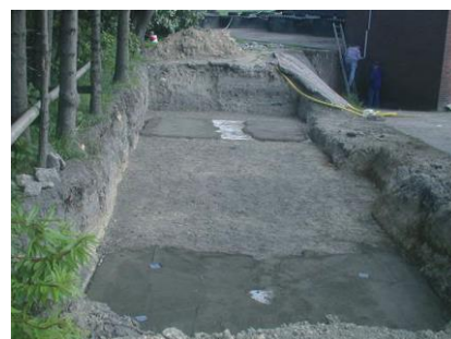
Aushub mit Streifenfundamenten
