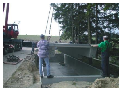
Einheben der Brücke
