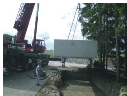
Einheben des Grubenelementes
