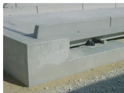
Fertigteil-Fundamente zur Aufnahme der Brücke
